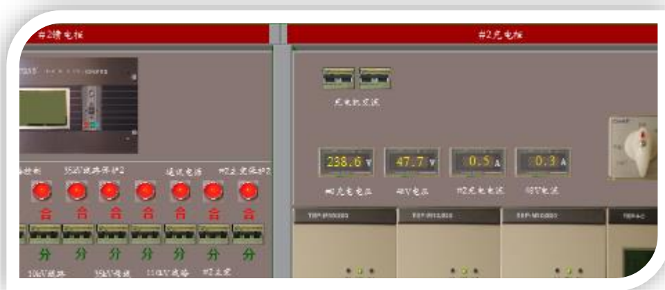
图 6-11 检查充电柜、馈电柜
