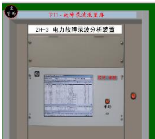
图 5-14 110kV 故障录波装置仿真屏
