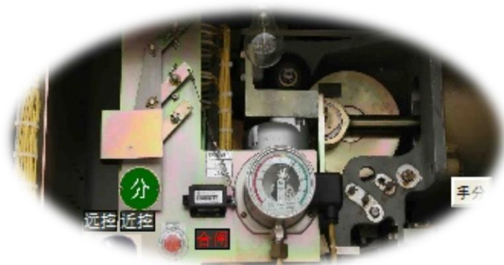
图 6-16 检查宗河线 1124 断路器分合指示
