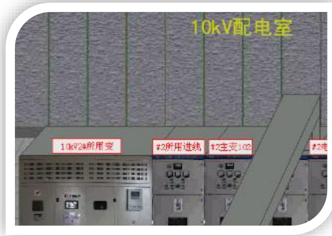
如图 5-20 所用变及操作柜界面
